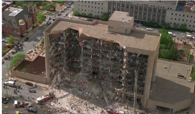
Figura 1. Colapso del edificio Alfred P. Murrah en 1995 en la ciudad de Oklahoma, E.E. U U
