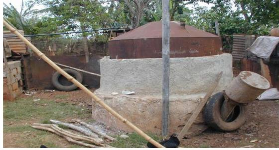
Figura 1. Biodigestor de campana flotante. (Sánchez J. V. y González A. , 2011)
