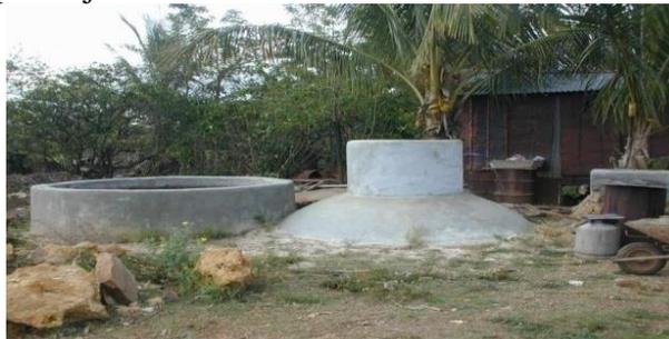
Figura 2. Biodigestor de cúpula fija. (Sánchez J. V. y González A. , 2011)
