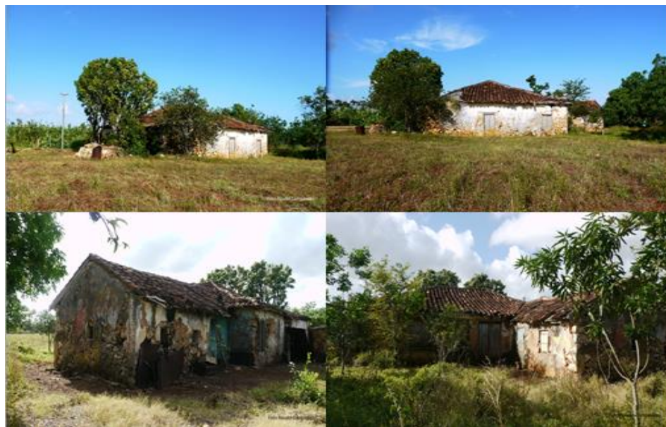
Figura 1. Vista Externa. Fuente: Elaboración propia
