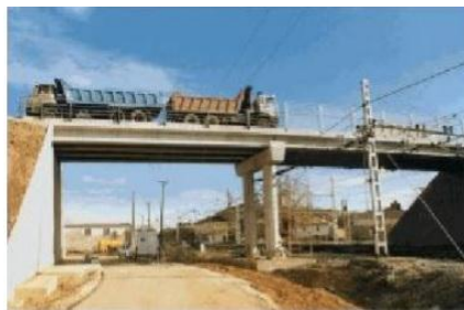
Fig. 1. Ilustración de la ejecución de una prueba de carga estática.
