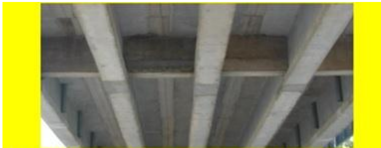
Fig. 6 Unión de los dos tramos de vigas longitudinales con concreto colado in situ. En la figura se observa, además, el diafragma central y los pasatubos del drenaje superior.
