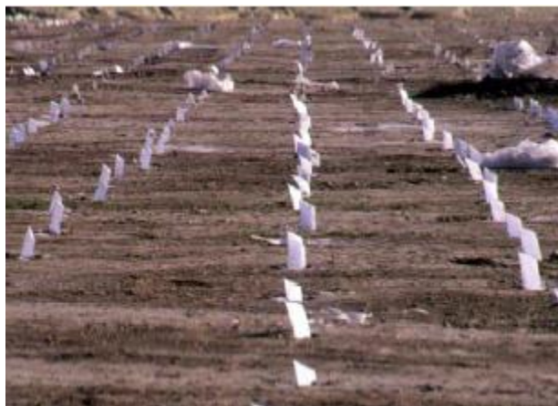
Figura 13. Mechas Drenantes instaladas. Fuente: (De Córdoba, 2003).
