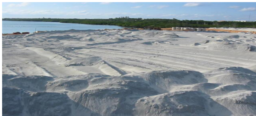
Figura 20. Método de Precarga en Marina Gaviota Fase III, Varadero. Fuente: (Granadillo, 2015).
