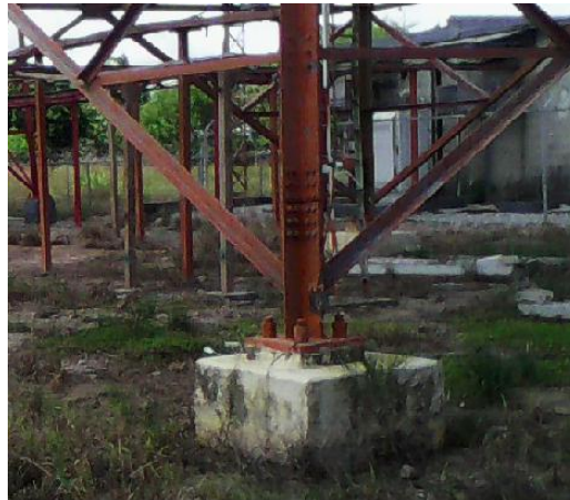
Figura 7. Apoyos de una armadura espacial.
