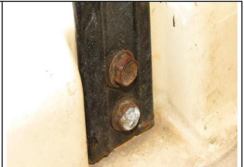
Figura 18. Unión con perno mal protegida en la parrilla al carro.
