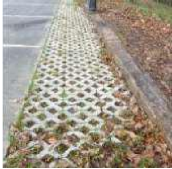
13; 14) Drenes laterales utilizados en las vías y empleo de adocretos.
