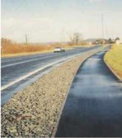
13; 14) Drenes laterales utilizados en las vías y empleo de adocretos.
