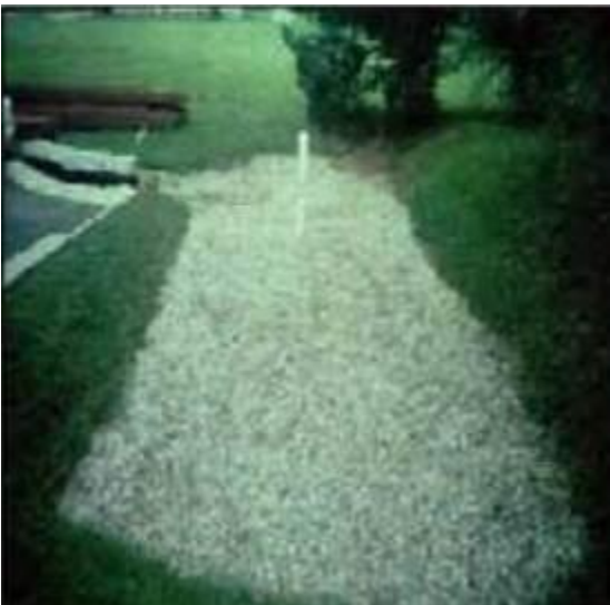
(12) Zanja de infiltración (rellena con grava)
