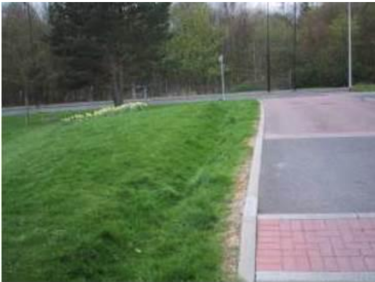
15) Cunetas revestidas con vegetación (césped con “firme” permeable)
