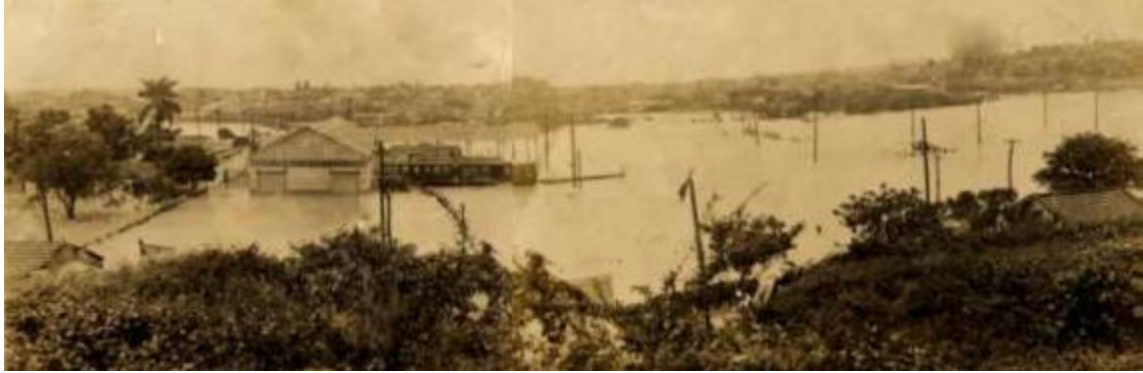
(8) Inundación en la zona aledaña a la estación ferroviaria de “Hershey” (1933)
