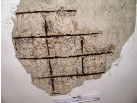
Foto No 1 Fallo del recubrimiento por oxidación de los aceros de la losa
