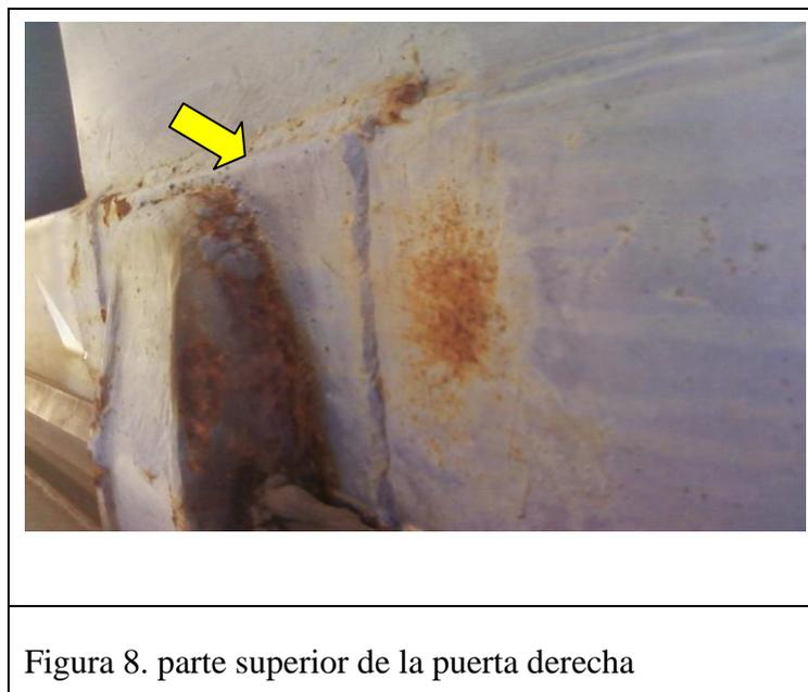
En Fig.2 y Fig. 8, con flecha roja se observan los problemas que ocasionan un mal diseño anticorrosivo por imperfecciones de la soldadura. En todos los casos se presenta una corrosión localizada. En todos los casos tiene lugar un deterioro por corrosión de forma prematura, es decir en las zonas donde existen problemas de diseño anticorrosivo, se producen primero los fallos por corrosión.
