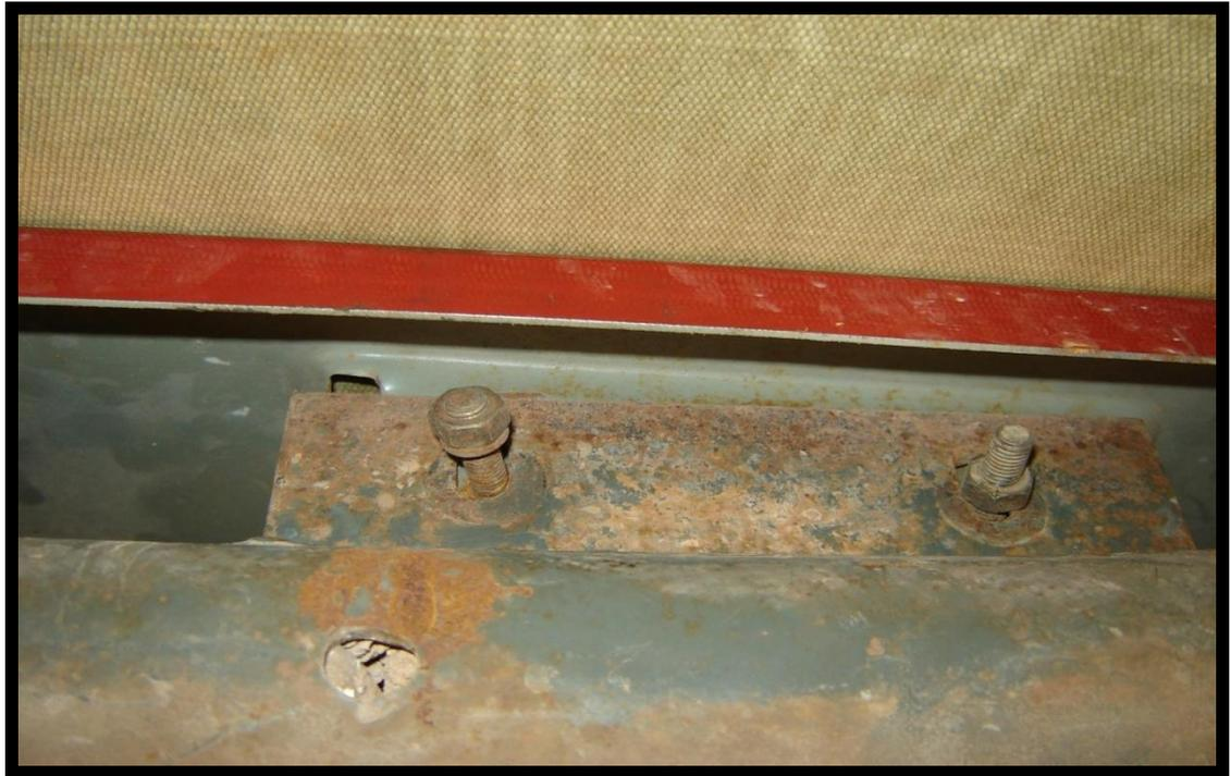
**Falta de relleno con soldaduras en orificios.**
