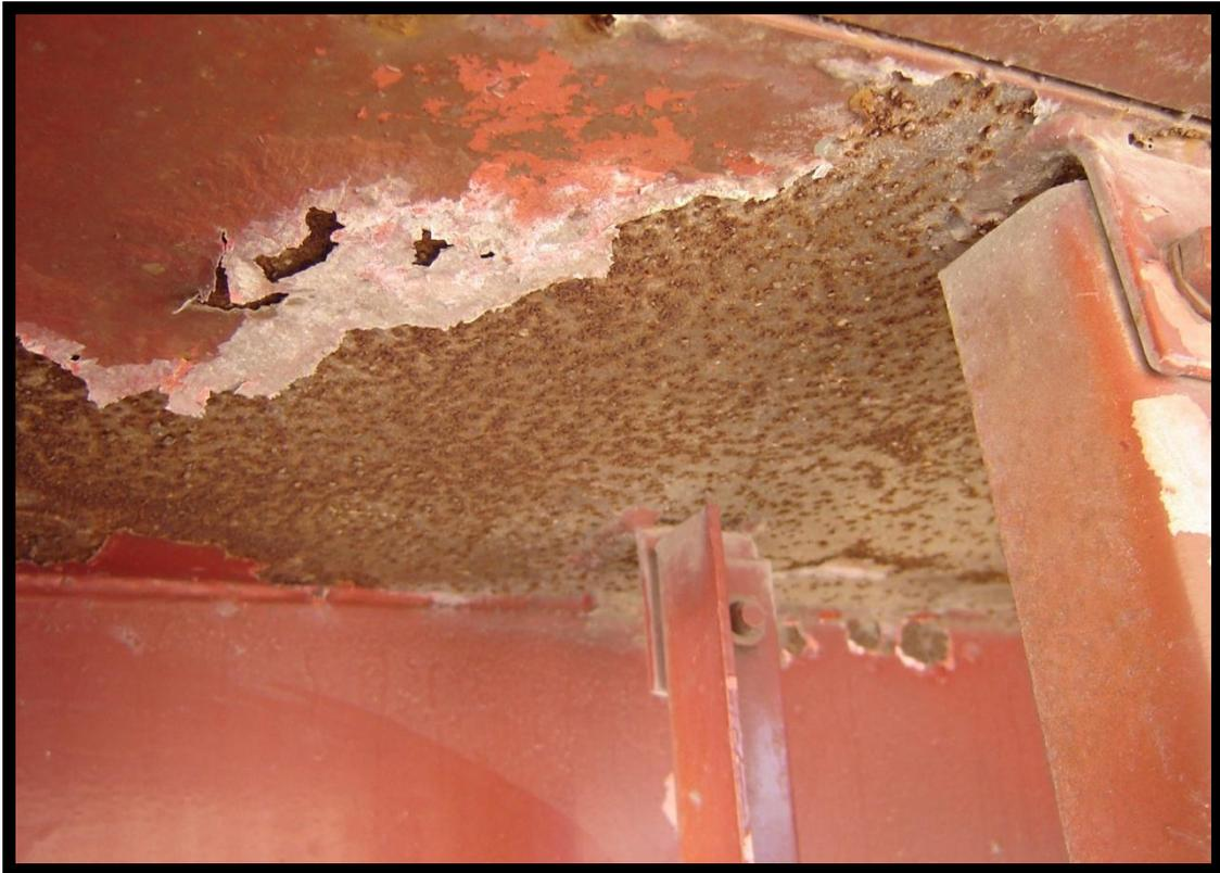
Aplicar disolución de fosfatado y después pintar.
