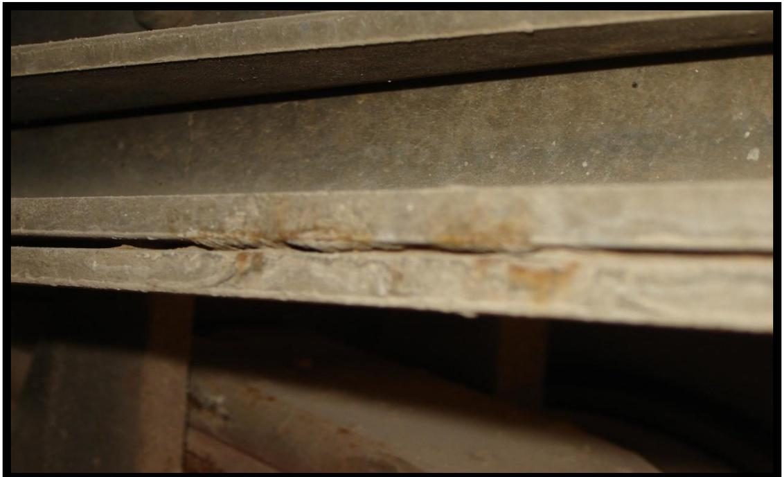
Utilizar el DISTIN 403 y grasa líquida DISTIN 305L después de eliminar corrosión por el método manual mecanizado, posteriormente sellar
