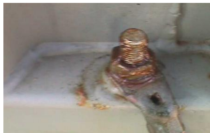
Fig.3.11. Pernos, tuercas y arandelas desprotegidos donde se sujeta el radiador.
