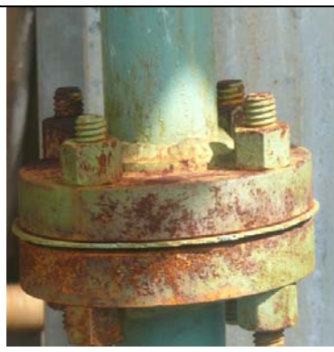
Fig. 5. Conexiones con pernos. Observe los resquicios entre las bridas y junta.
