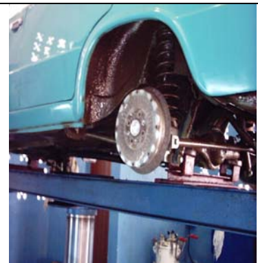
Fig. 9. Área cerrada de la bóveda de un auto sin el cobertor plástico. Se observa grasa aplicada.
