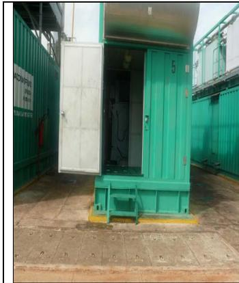
Fig. 10 Componente hueco entre el piso y la base del contenedor.
