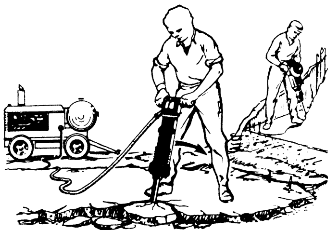
FIG. 276. Desagregación con martillo rompedor.
