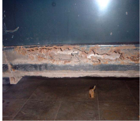
Fig. No 30. Componente hueco sellado con acumulación de humedad. Observe el avance de la corrosión desde el interior de la estructura, que no está protegida interiormente.
